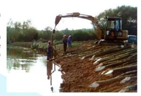
Les fagots sont placés entre les pieux (ramilles dirigées vers l'aval) puis maintenus à l'aide de fil de fer tendus entre les pieux en quinconce. Le fil de fer doit être maintenu sur le pieux soit en réalisant une encoche, soit avec un crampillon métallique (voir photo et schéma ci-dessous).
