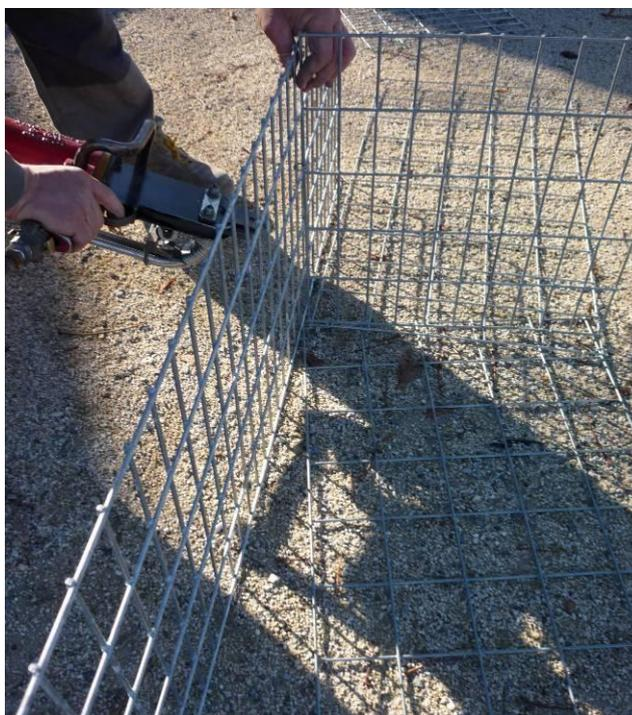
4) fixer les panneaux (avant et arrière) sur les cloisons et les panneaux de fond
