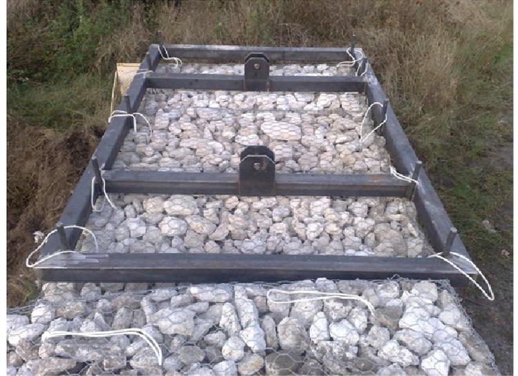
Lorsqu'il est important de travailler sans dommage et sans déformation des matelas, ce type de palonnier avec sangles perdues, est une solution.
