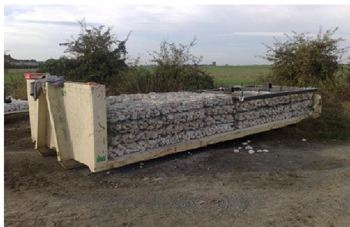
Nos matelas disposent de « véritables » diaphragmes : des cloisons indépendantes, prédisposées tous les mètres, déjà liaisonnées et renforcées d'un fil en tête de plus gros diamètre, qui facilite l'agrafage du couvercle.
