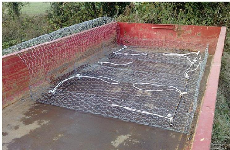
Afin de limiter la manutention et renforcer la sécurité, les matelas sont remplis directement dans la benne (voir notice de mise en œuvre)
