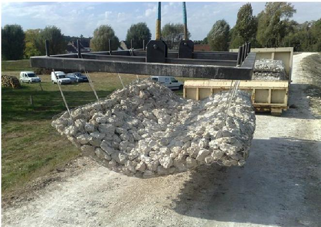
En présence d'eau, la norme NF EN 94 325 - 2, Ouvrages en gabions en grillage métallique à maille hexagonale double torsion, T3 Partie 2 : Ouvrage en site aquatique prescrit pour les gabions tissés double torsion, l'utilisation de grillages plastifiés.
