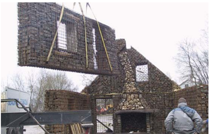
Des panneaux de treillis, des cailloux, une grue et cela devient un jeu de construction.
