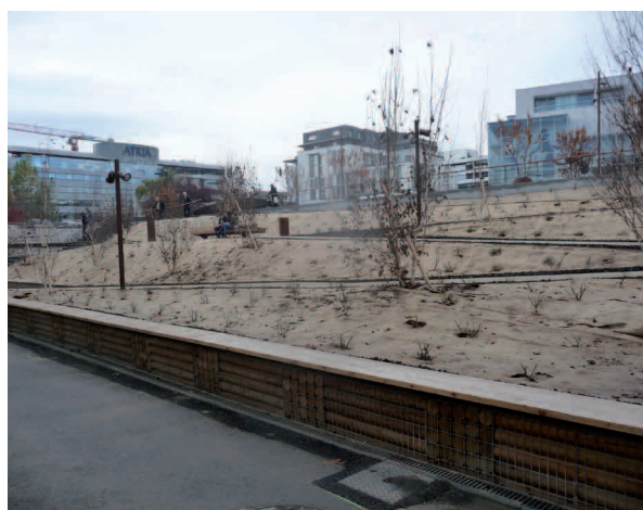
Aménagement de la place Grimault à Annecy, face au Cinéma (74). Remplissage de la face avant avec rondins de Mélèze et l'arrière avec des granulats. Assise en Mélèze.
