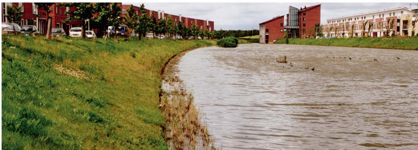
Juin 2000 : L'installation des géonattes et boudins de fibres coco est achevée
