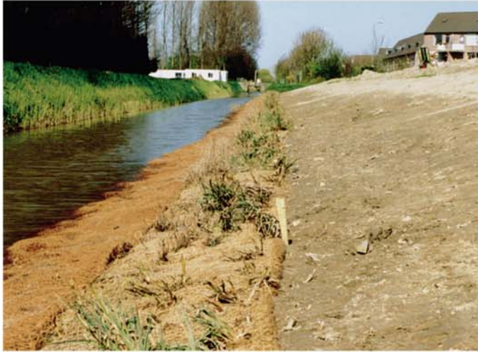
Avril 2000: Installation des géonattes coco pré-végétalisées AquaFlora et des tapis filtrants. Le niveau de la mer est au niveau hivernal.
