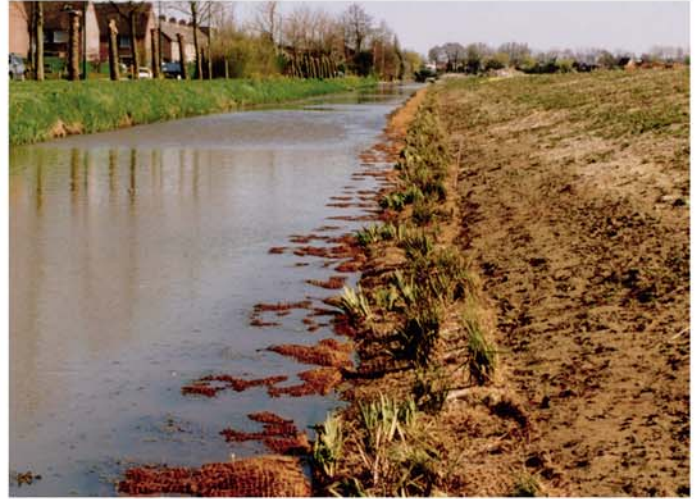
Avril 2000: Installation des géonattes coco pré-végétalisées AquaFlora et des tapis filtrants. Le niveau de la mer est au niveau hivernal.
