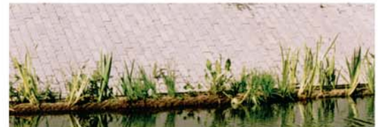
Mai 1997 : les boudins prévégétalisés sont posés au pied des perrés en béton.
