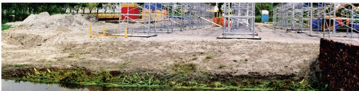
Juillet 2001 : Les géonattes coco viennent d'être installées.
