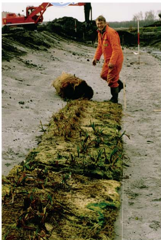
Janvier 1998 : Pose des géonattes coco
