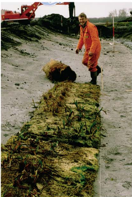
Janvier 1998 : Pose des géonattes coco
