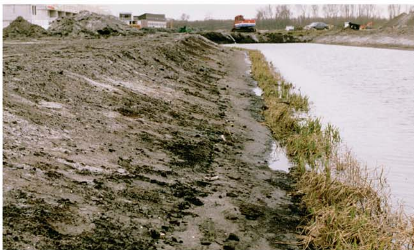
Février 1998 : Fin de la première tranche de travaux.
