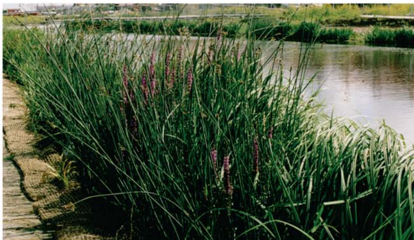
Juillet 1998 : La végétation dans les géonattes pré plantées s'est développée très rapidement et forme une barrière rivulaire dense et très colorée.
