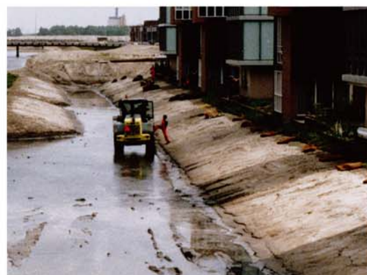
Mai 2004 : Les géonattes coco pré-végétalisées sont installées à sec sur le haut des berges
