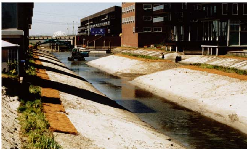
Mai 2004 : Les géonattes coco pré-végétalisées sont installées à sec sur le haut des berges
